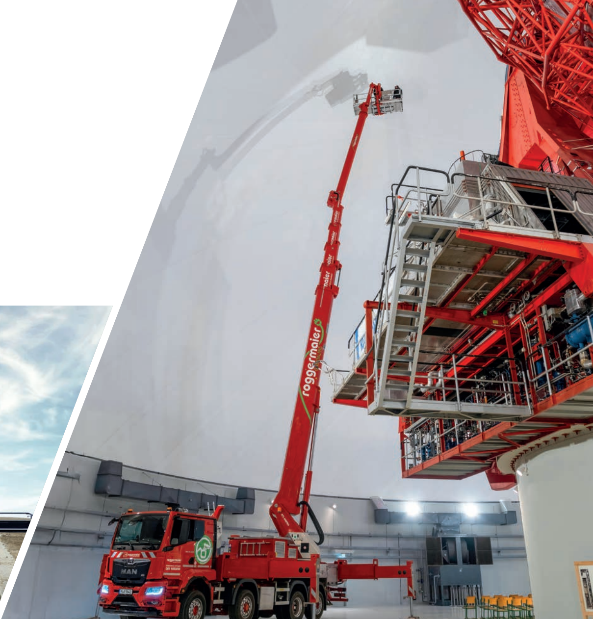
Wartung einer Parabolantenne mit Hubarbeitsbühne innerhalb einer Radarkuppel
