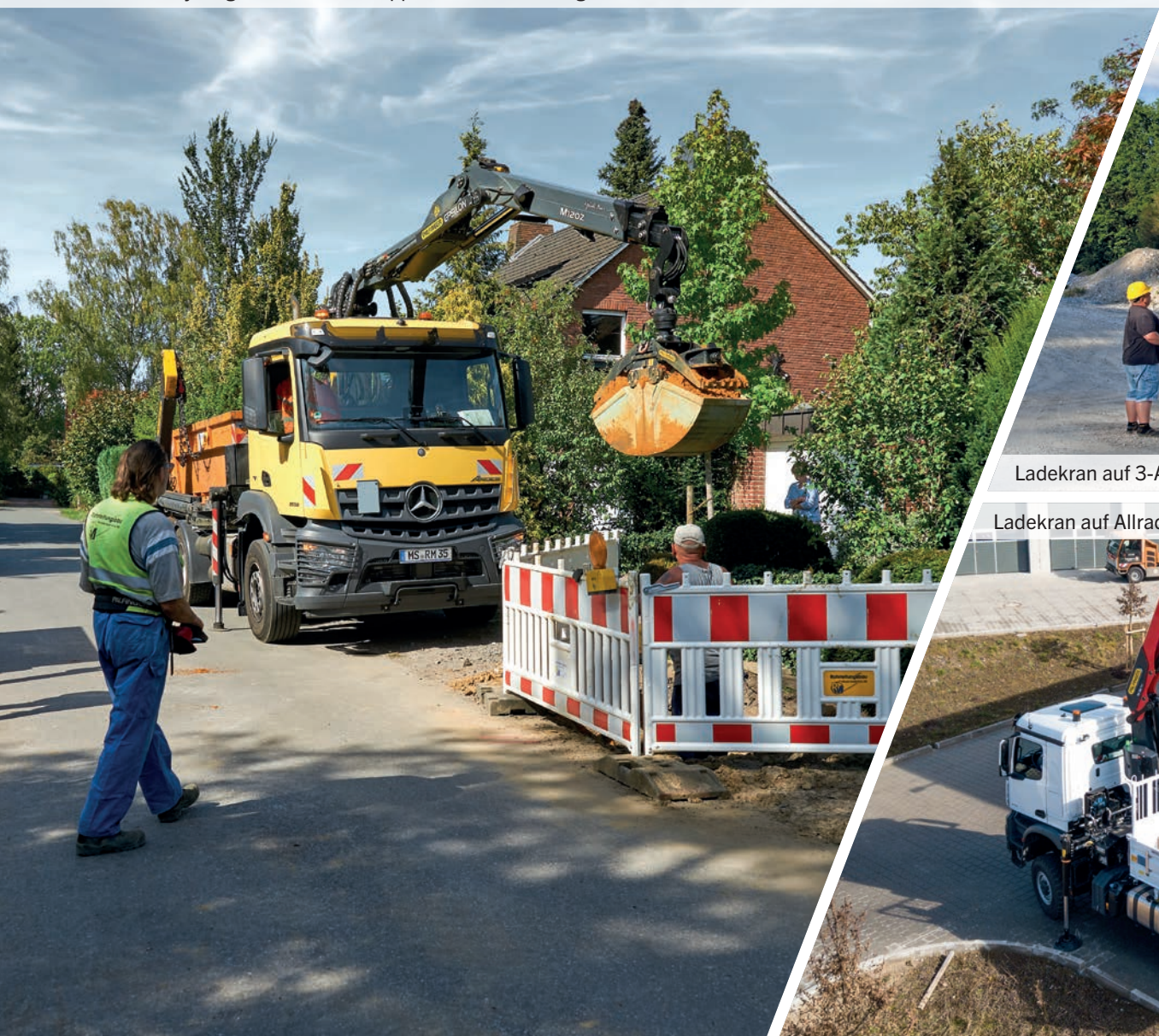
EPSILON Recyclingkran mit Absetzkipper beim Rohrleitungsbau
