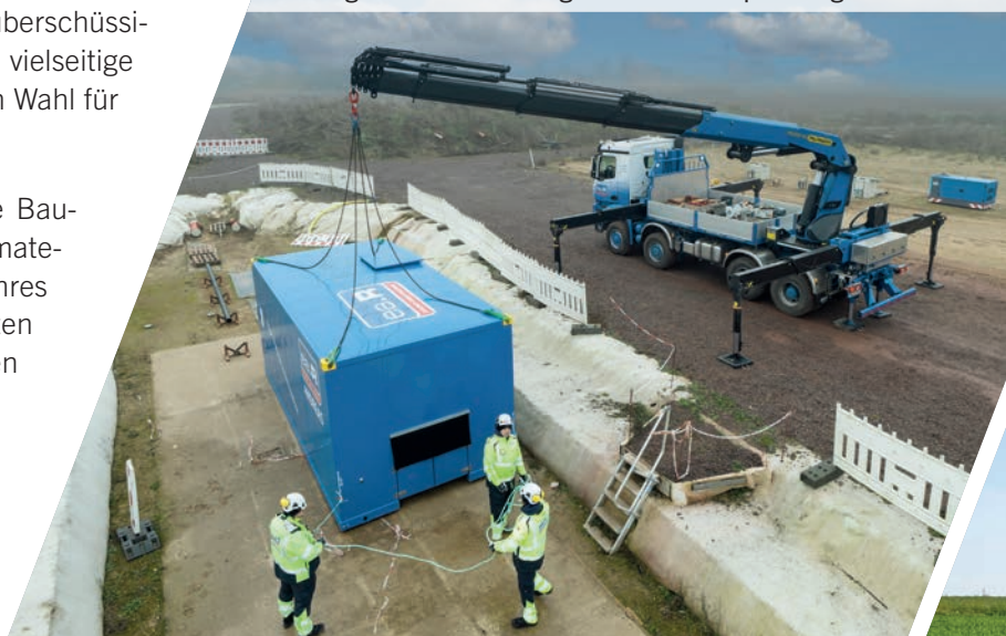
Montage einer Verbindungsbox für Hochspannungskabel mit Schlingenseilzugwinde
