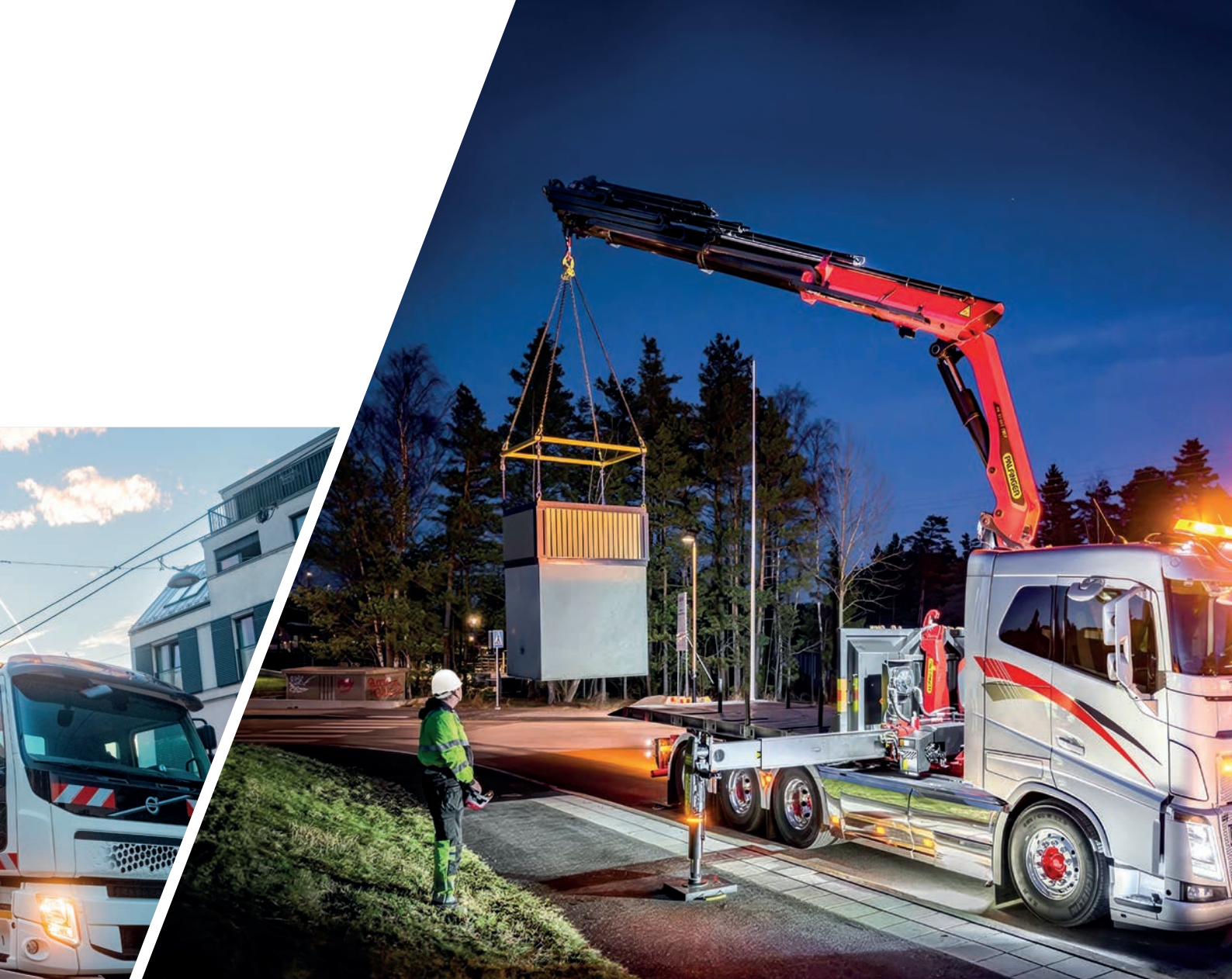
Montage eines Transformators mit Ladekran
