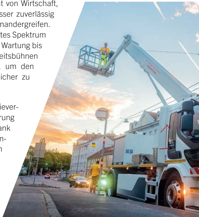
Instandhaltung des Leitungsnetzes mit Hubarbeitsbühne
