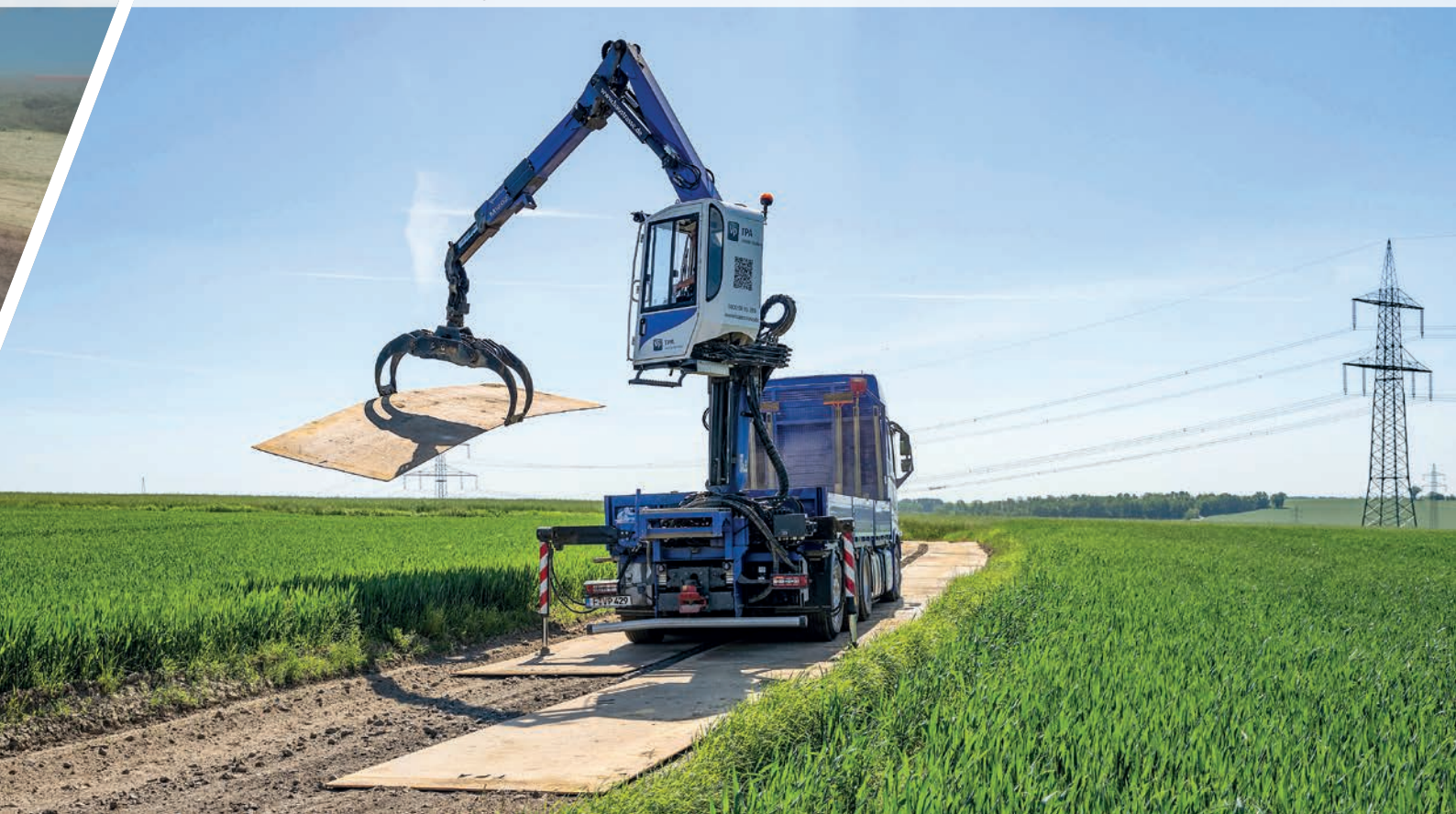
Bau einer mobilen Straße mit Stahlplatten durch PALFINGER EPSILON Kran
