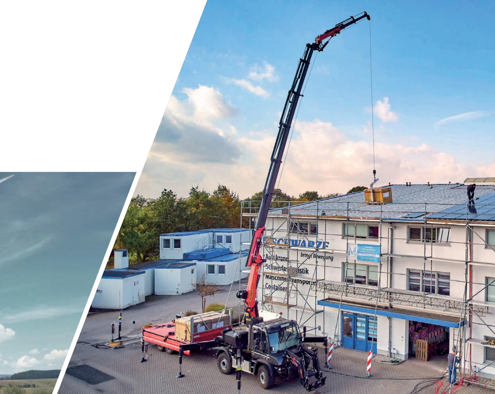
Aufbringen von Solarmodulen auf Firmendach mit Ladekran und Seilwinde
