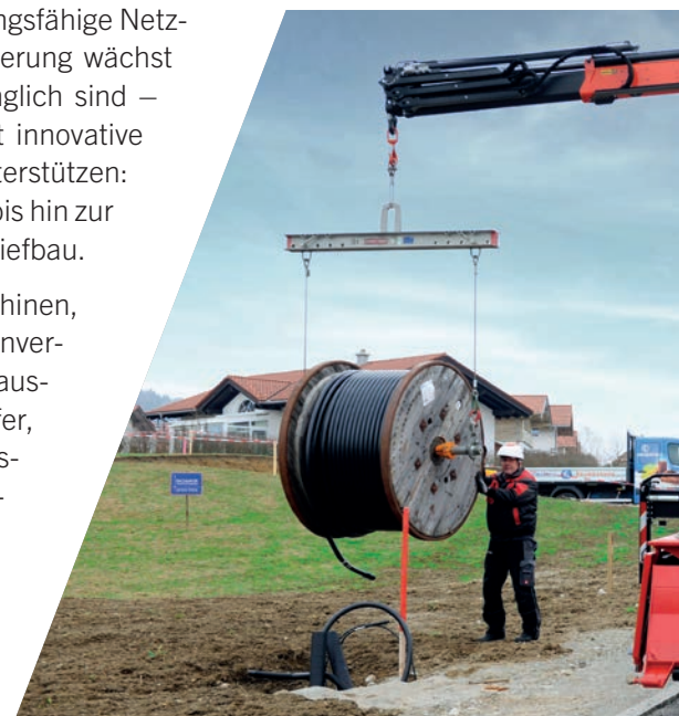
Ladekran auf Kipperfahrzeug beim Verlegen von Stromleit
